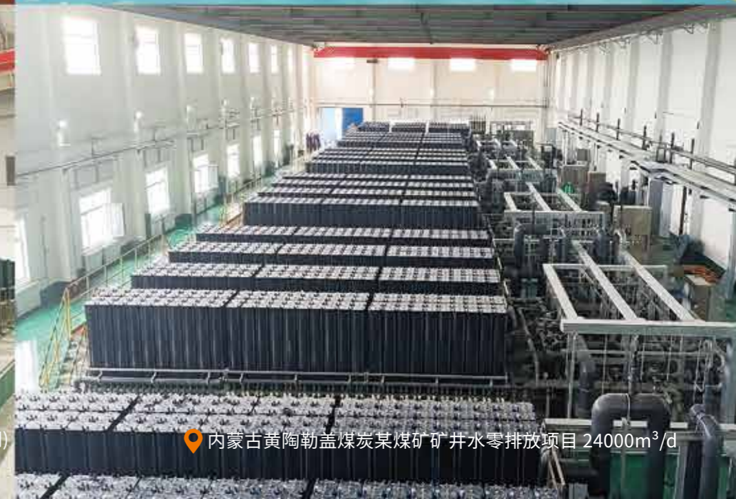
陕西元盛煤业有限公司某煤矿矿井水处理项目 15600m 3 /d(一期) 28800m 3 /d(二期)
